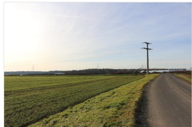
2) Nördliches Plangebiet mit Freileitung und westlich gelegenen Solarpark. © Klärle GmbH (2025)
